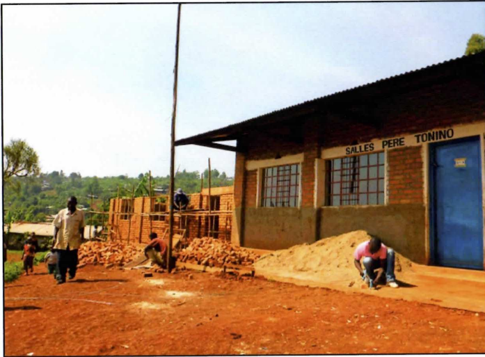
L'ottava classe della Scuola Primaria "Père Tonino" in costruzione nella Parrocchia di Cahì (Bukavu)
